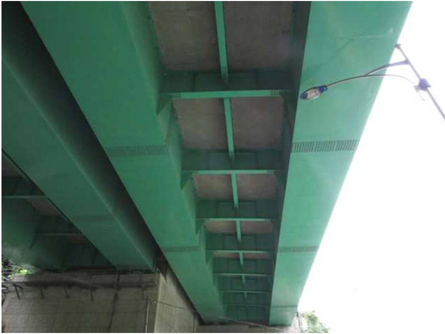
바닥판하면 및 강박스 외부전경
